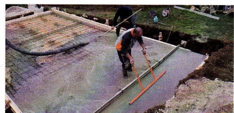
Rénovation du soubassement et extension d'un chalet.
