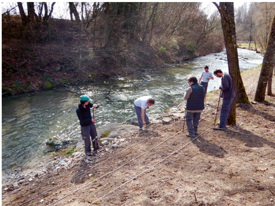
Mise en place des boutures par l'équipe d'Alvéole au parcours santé du Foron à Fillinges
