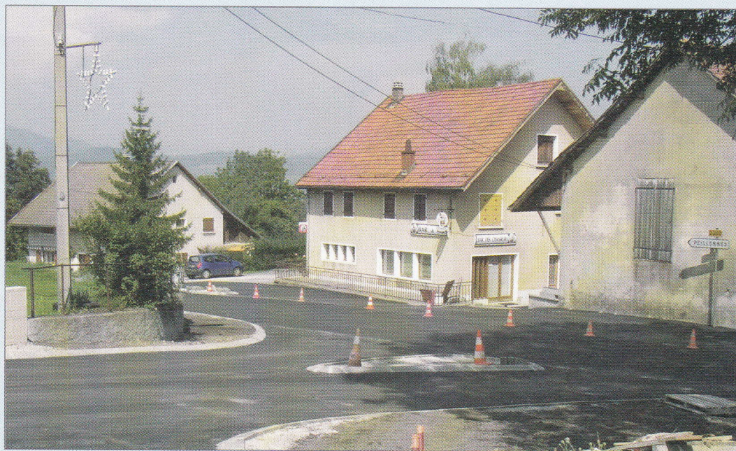
Aménagement du croisement de la RD 20 et de la RD 200
