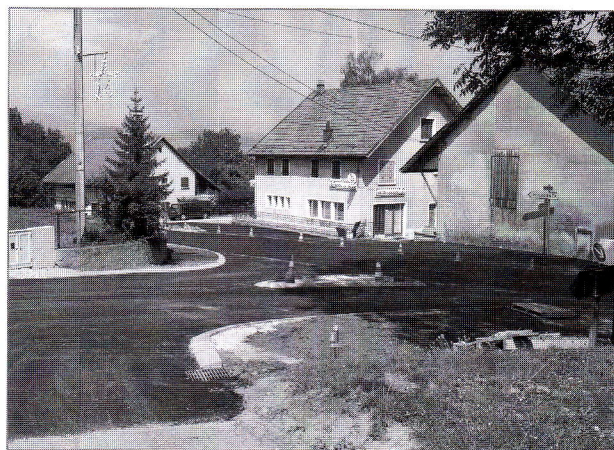
Aménagement du croisement de la RD 20 et de la RD 200
