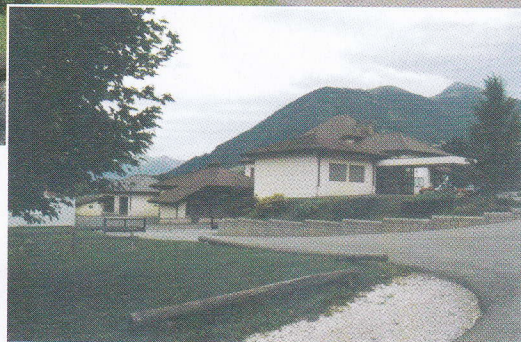
L'école publique de St-Jean de Tholome avant et après le réaménagement
